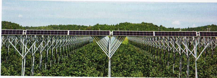
匝瑳メガソーラーシェアリング第一発電所、空撮。2017年度(初年度)は、予想年間売電収入4700万円を大きく超える、5400万円の年間売電収入が得られた。/設備容量:1MW、土地面積:約3200㎡、導入年月日:2017年3月、導入費用:約3億円
